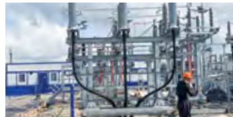
ООО «ГЭМ» монтажные работы по реконструкции ПС 110/6 кВ «Нововеличковская» → стр. 5
