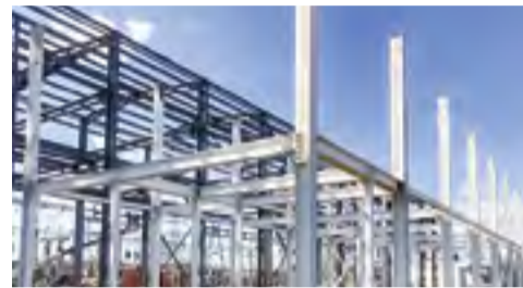
АО «ГЭМ» строит ПС 220 кВ «Старт» в Хабаровском крае → стр. 4
