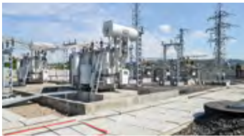
Специалисты БМУ ГЭМ построили ПС 35 кВ «Боково» в Иркутске → стр. 3
